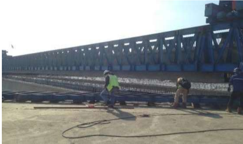
Gambar 4. Proses Erection Menggunakan Launching Gantry (Sumber : Peneliti, 2021)
