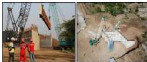
Gambar 3. Erection Menggunakan Crane (Sumber : Peneliti, 2021)
