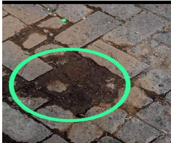
Gambar 7. Genangan Air yang Menunjukkan Titik Rencana Pemasangan Biopori di Area Lain yang sering Terjadi Genangan
