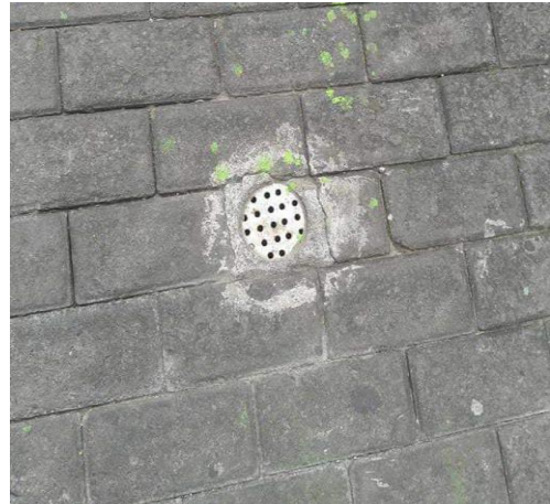
Gambar 12. Pemasangan Biopori setelah Dirapikan dengan Semen
