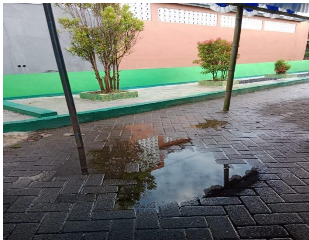
Gambar 6. Genangan Air yang Menunjukkan Titik Rencana Pemasangan Biopori di Area Masjid
