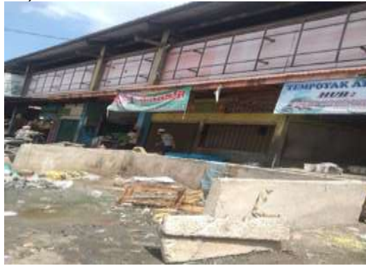
Gambar 2. Tempat Penampungan Sementara (TPS) dalam Kondisi Rusak
