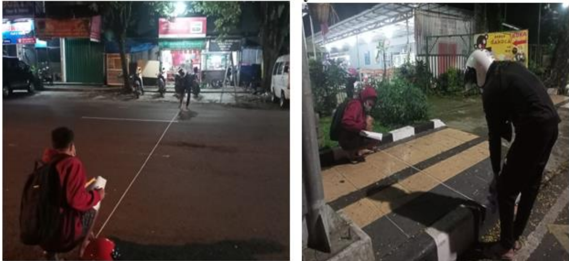
Gambar 3. Survey Geometrik Jalan
