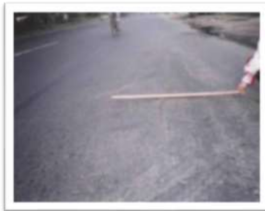
Gambar 13. Jembul (Upheaval) Sumber: Bina Marga No.03/MN/B/1983
