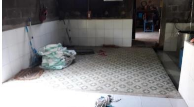
Gambar 1. Proses perbaikan lantai dapur produksi tahu Kp. Cijambe, Kecamatan. Cikarang Selatan
