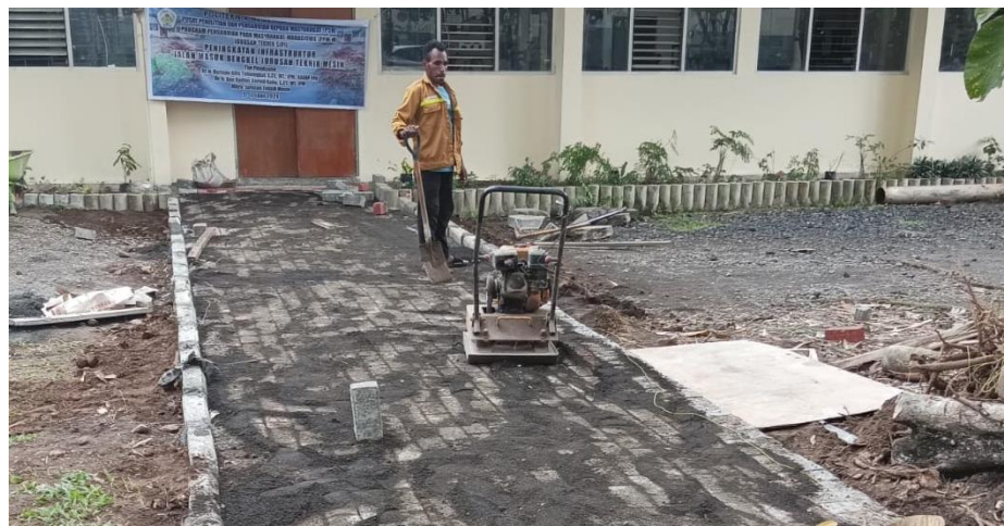
Gambar 6. Penghamparan Material Pasir Mengisi Celah Paving Blok
