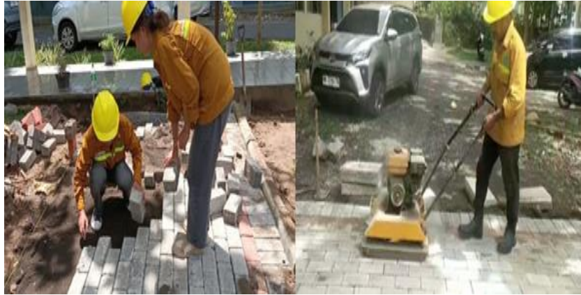
Gambar 5. Pemasangan Dan Pemasatan Paving Blok
