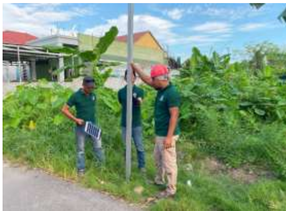
Gambar 5. Pemasangan Tiang Lampu Penerangan Jalan
