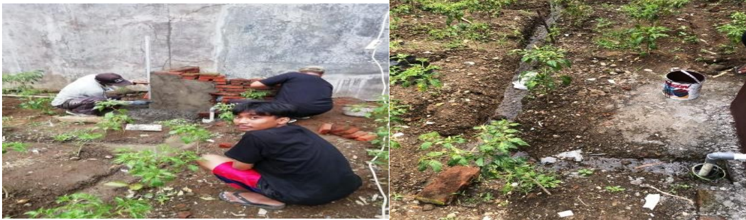
Gambar 4. Pemasangan Saluran Pipa Irigasi
