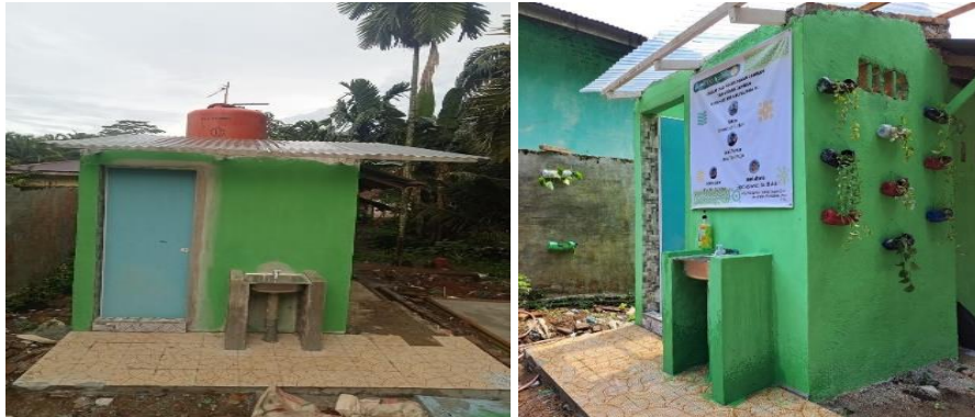
Gambar 12. Penyempurnaan akhir jamban (pembuatan septic tank, pemasangan seng, pengecatan, pembuatan taman, dll)
