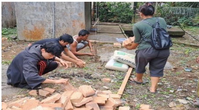
Gambar 11. Pembangunan struktur dan pondasi jamban
