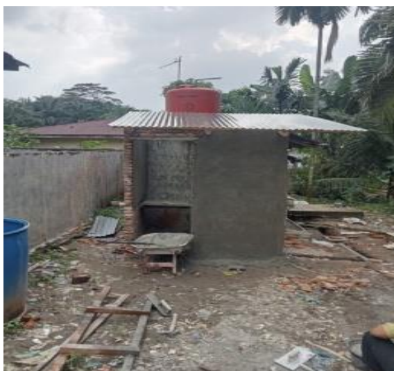
Gambar 12. Pemasangan dinding jamban, pembuatan kerangka pintu, dan pemasangan kerangka atap
